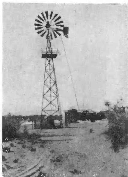
Фиг. 7. Ветровой двигатель, установленный на опытном участке Репетекской песчаной станции ВИРА. 1936. Фот. М. Петрова.
